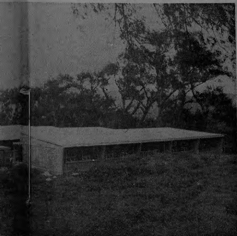
as instalaciones en construcción.
